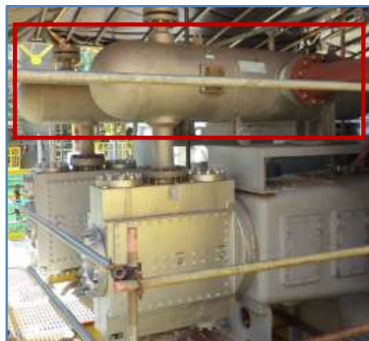
Figura 7 – Vasos de pressão localizados na sucção e na descarga de máquinas.
